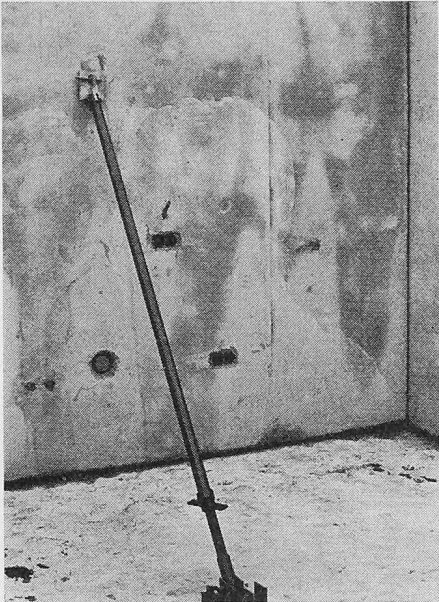
Bild 2. Zwischenwandplatten mit tapezierbereiter Oberfläche und Installationseinlagen. Abstützen und justieren mit Hilfe von Teleskopstreben (System Peikert)
