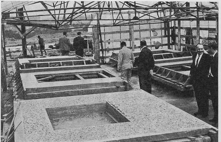
Bild 11. Fertig montierter «Grundriss», bereit für die Montage der Deckenplatten. Ueberbauung «En Champs Mogins» in Nyon (System Igeco)
