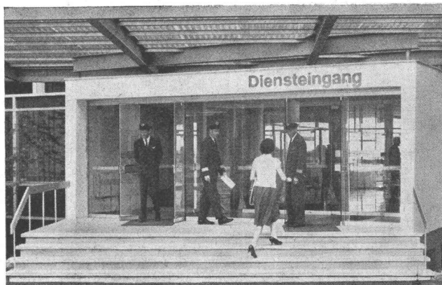
TORMAX im Flughafen Zürich-Kloten: acht Ganzglas-Doppeltüren, angetrieben durch je einen TORMAX-1. Die Steuerung erfolgt durch Kontaktteppiche.
