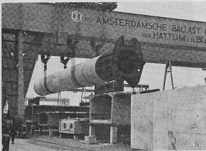
Bild 16. Transport eines Pfahles über das Werkareal
