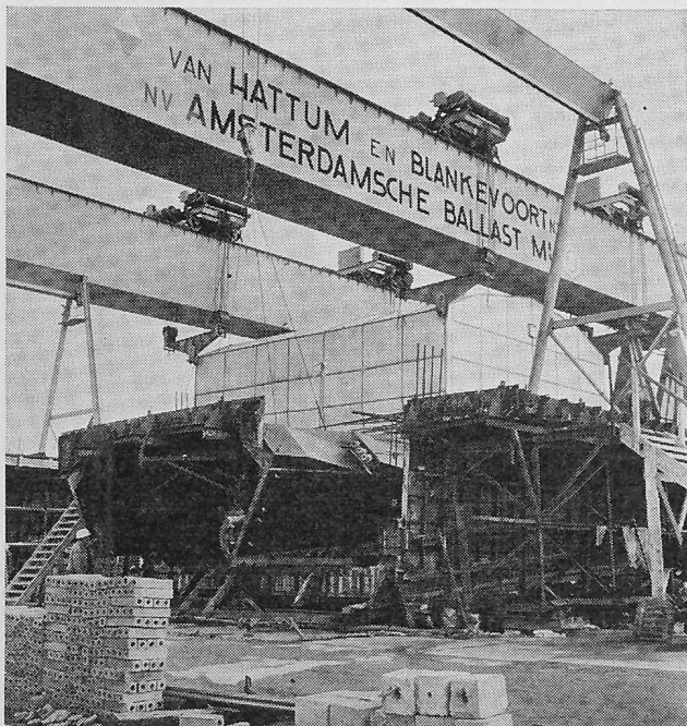
Bild 25. Die Innenschalung für die B-Einheit wird eingefahren
