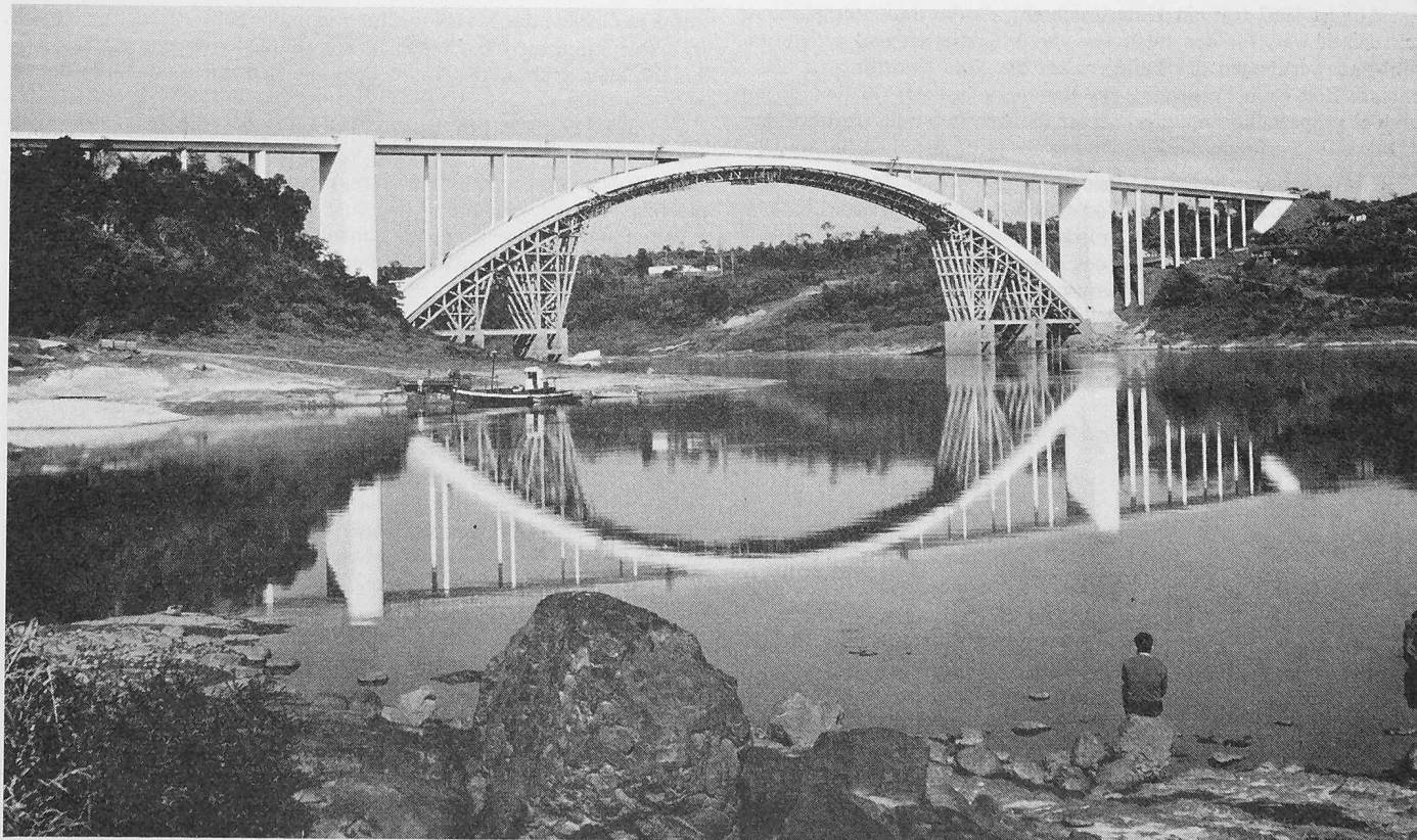
Ansicht der Brücke bei Niederwasser. Bei Hochwasser standen die untersten horizontalen Streben des Fächers des Lehrgerüst-Bogens in den Fluten des Rio Paraná
