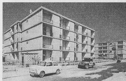
Bild 3. Wohnhäuser, wie sie in Israel mit vorgefertigten Elementen, System «Rastrom», erstellt werden
