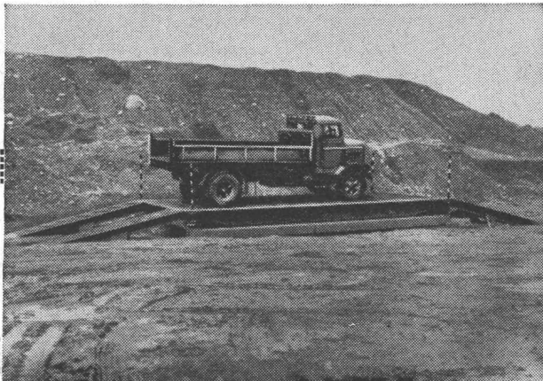
Einsatz im Autobahnbau
