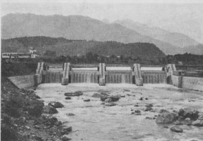
Bild 5. Gesamtbild des Wehres
