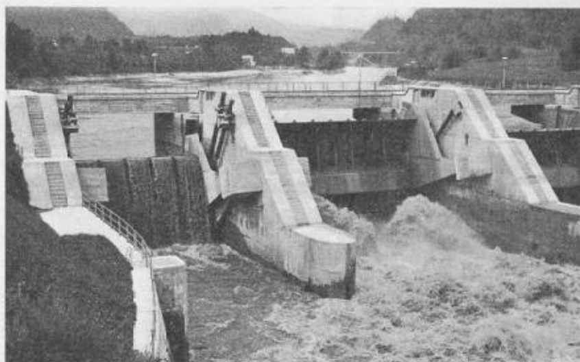
Bild 11. Spülöffnung (links) und Regulieröffnung (rechts)
