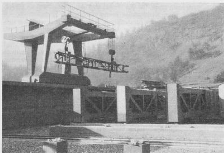
Bild 8. Dammbalkendepot mit Versetzkran
