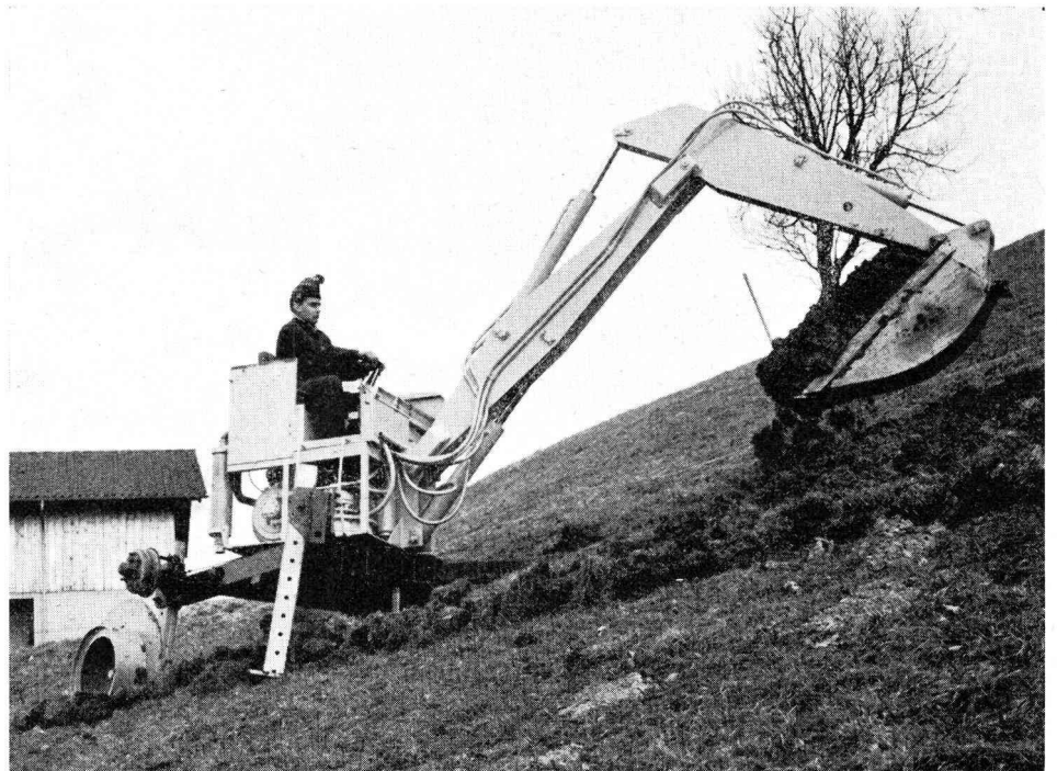
So arbeitet der MUK 3000 am Hang.
