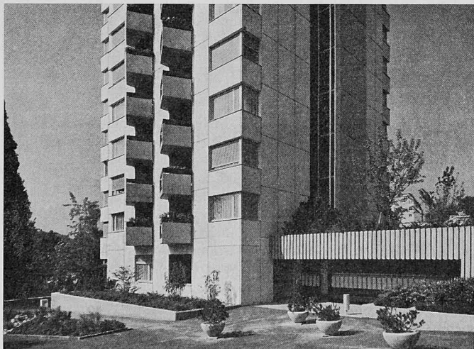
Haupteingang mit Milch- und Briefkastenanlage
