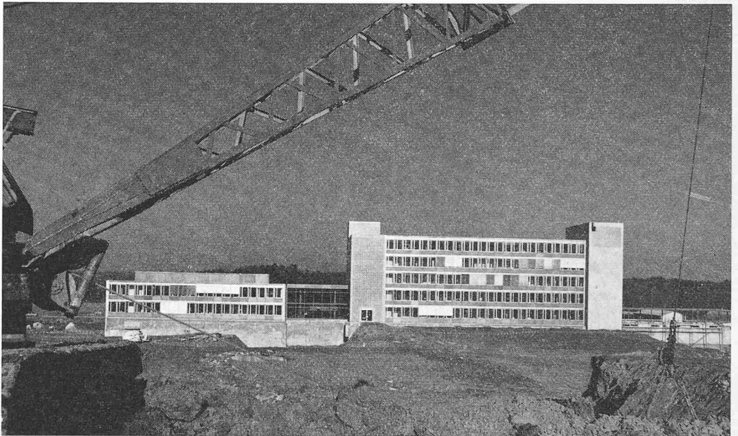
Bild 16. Ostansicht Technische Physik (links) und AFIF (rechts)
