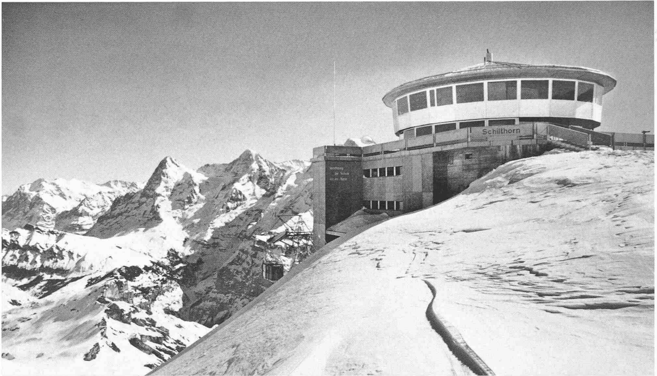
Gipfelstation der Schilthornbahn, 2970 m ü. M. Drehbares Aussichts-Restaurant auf dreigeschossigem Unterbau (Küche, technische Einrichtungen usw.); links davon Mönch und Eiger. Photo von Roll
