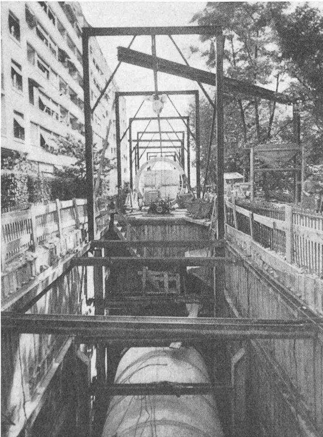
Bild 7. Rohr-Fabrikation an Ort und Stelle von Stossrohren vom Durchmesser 3,5 m. Mit Mono-Rail werden die 10 t schweren Einheiten mittels fahrbarem Elektrozug direkt vom Abhärteplatz zum Presssacht transportiert (Collecteur de l'Arve, Genève)
