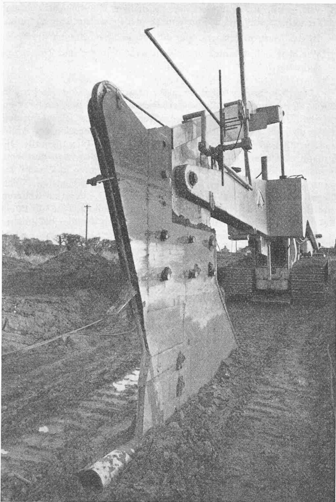
Bild 1. Automatische Rohrverlegungsmaschine «Badger Major»
