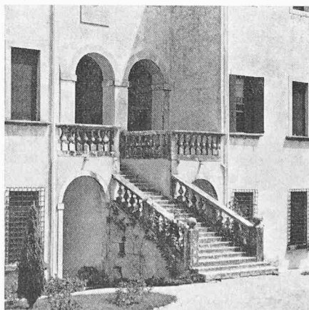
Villa Godi. Treppenaufgang zum Hauptgeschoss
