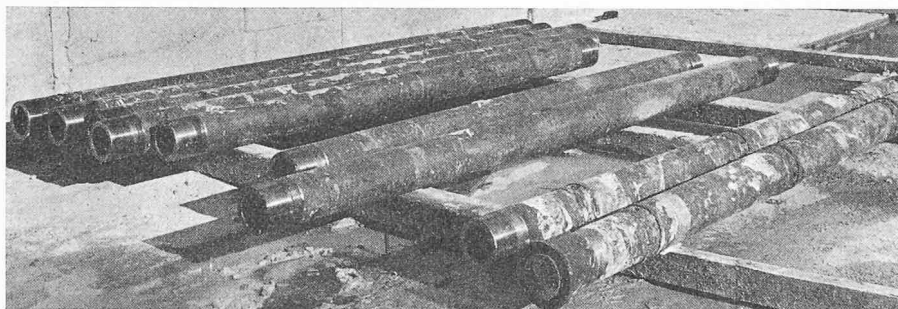
Bild 38. Lagerung der Stahlpfähle auf der Baustelle
