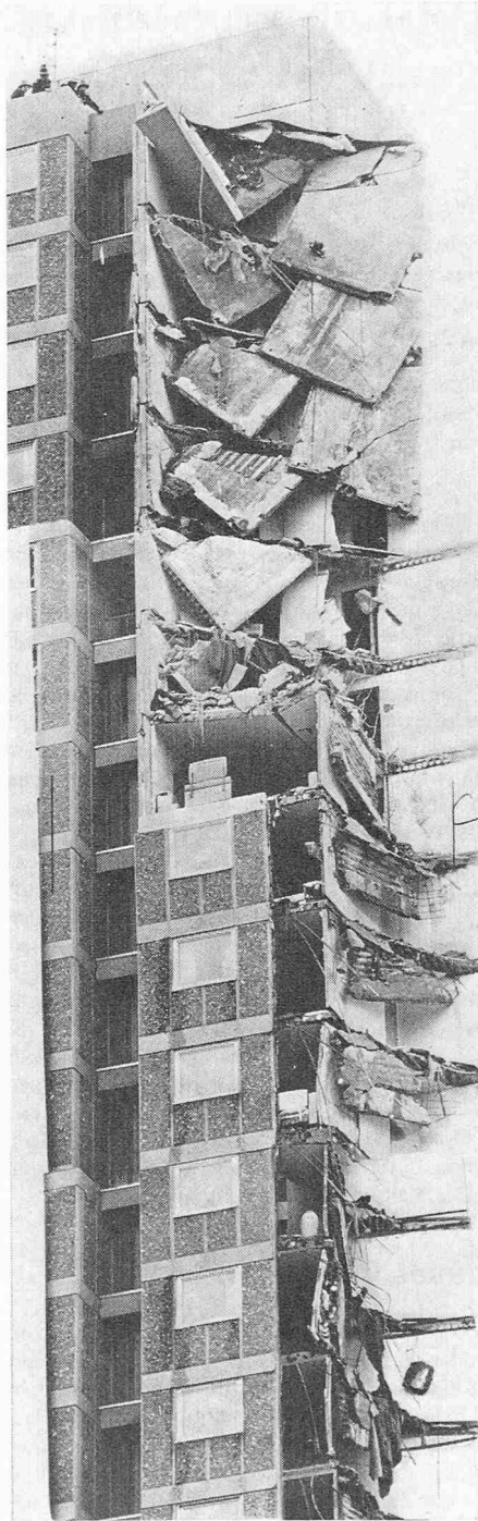
Bild 2. Oberer Teil, nach der Explosion, einige Zeit vor Bild 1 aufgenommen.
