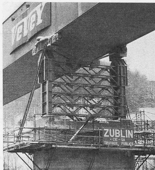
Bild 3. Autobahnbrücke über die Veveyse. Provisorische Pfeileraufbauten mit Rollenbatterien von 800 t Tragkraft (links) und 400 t Tragkraft (rechts)
