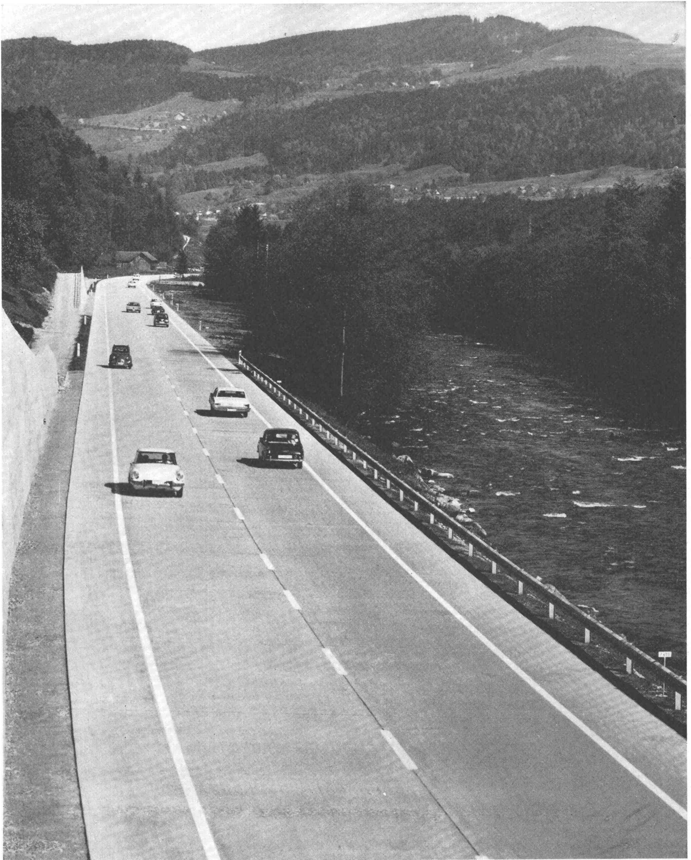
T 10, Bern—Luzern, Umfahrung Malters LU, Betonbelag
