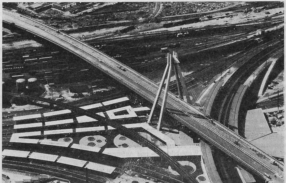
Bild 1. Hochstrasse im Bereich des neuen Ludwigshafener Hauptbahnhofs. Die gesamte Brückenanlage wurde von der Rheinstahl Union AG, Dortmund, gebaut
