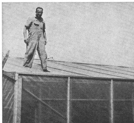
dank Gitterarmierung erstaunliche Reisskraft
