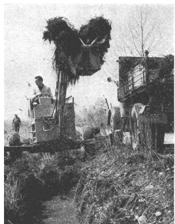
Arbeit mit dem Grabenlöffel
