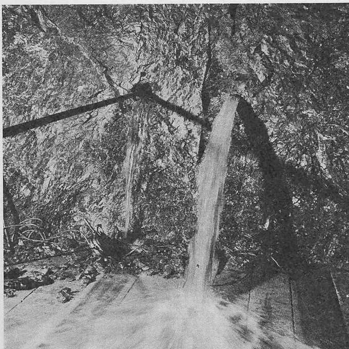
Bild 3. Vom standfesten Fels aus angebohrte wasserführende Kluft
