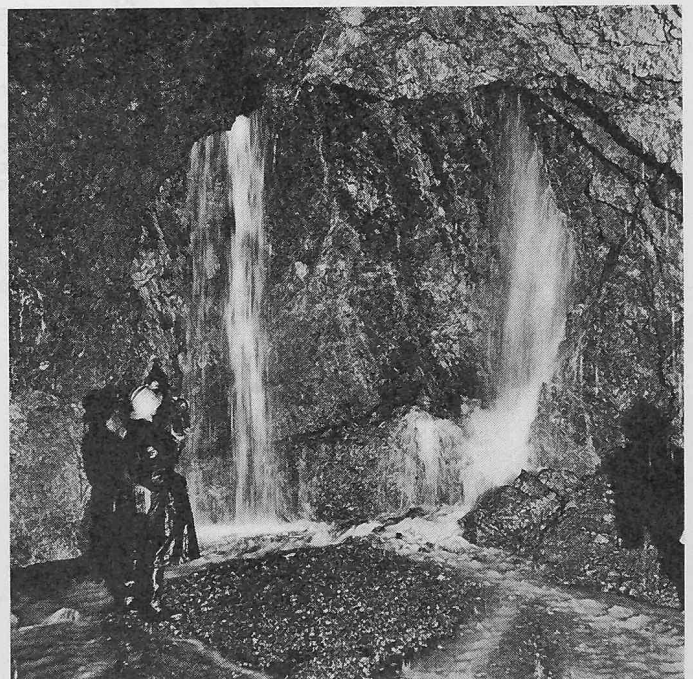
Bild 4. Steigender Druckstollen Sampuoir. Angefahrene Kluft bei Stollenmeter 160. Das ausgeschwemmte Material liegt zum Teil noch am Boden
