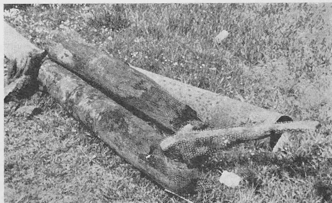
Bild 7. Auswirkungen von aggressivem Grundwasser auf verzinkte Stahlrohre
