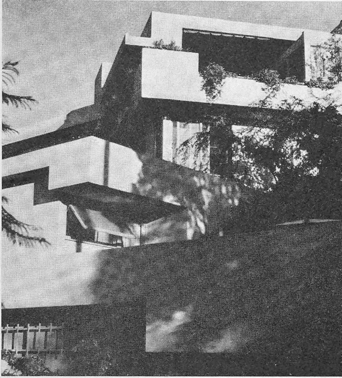
Ansicht von der Strasse
