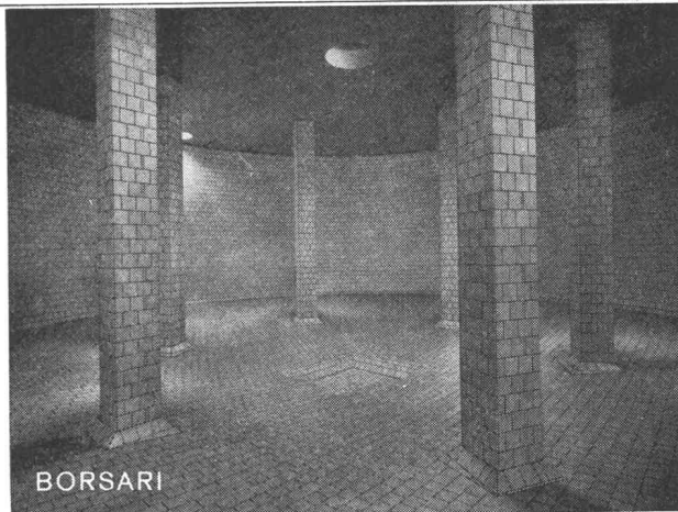
Flugplatz-Immobilien-gesellschaft, Kloten 7 Tanks total 5 600 000 Liter Heizöl
