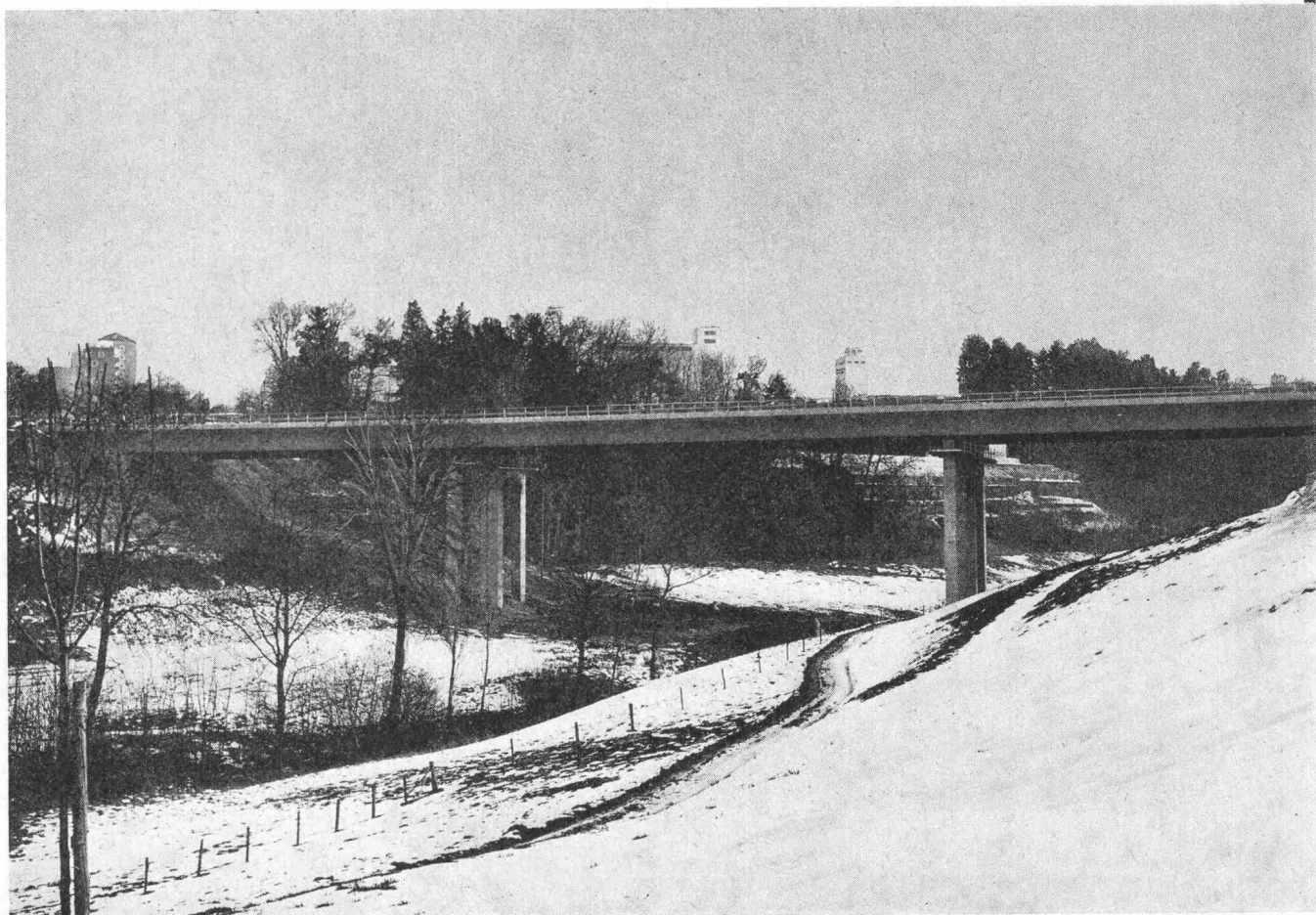
Viaduc de Guin, autoroute Berne—Vevey
