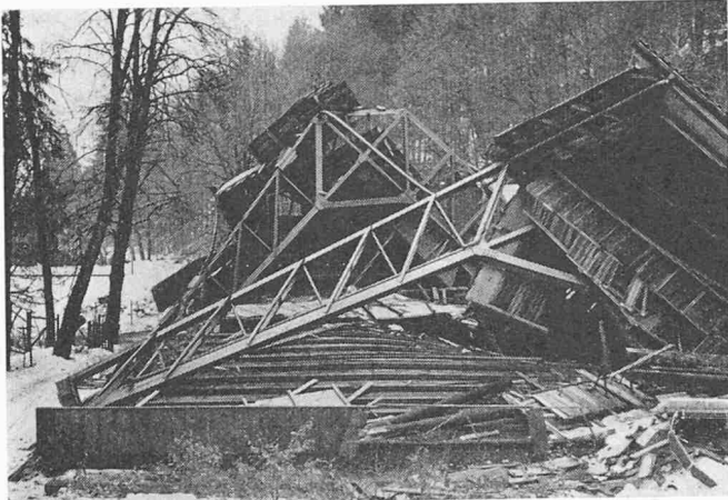
Bild 1. Das alte Tribürendach nach dem Einsturz
