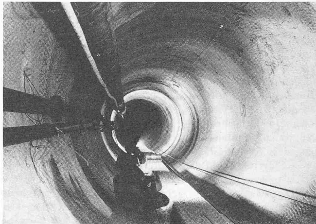
Bild 8. Ansicht des gebohrten Schachtes
