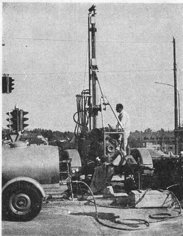
Sondierbohrung Bucheggplatz Zürich
