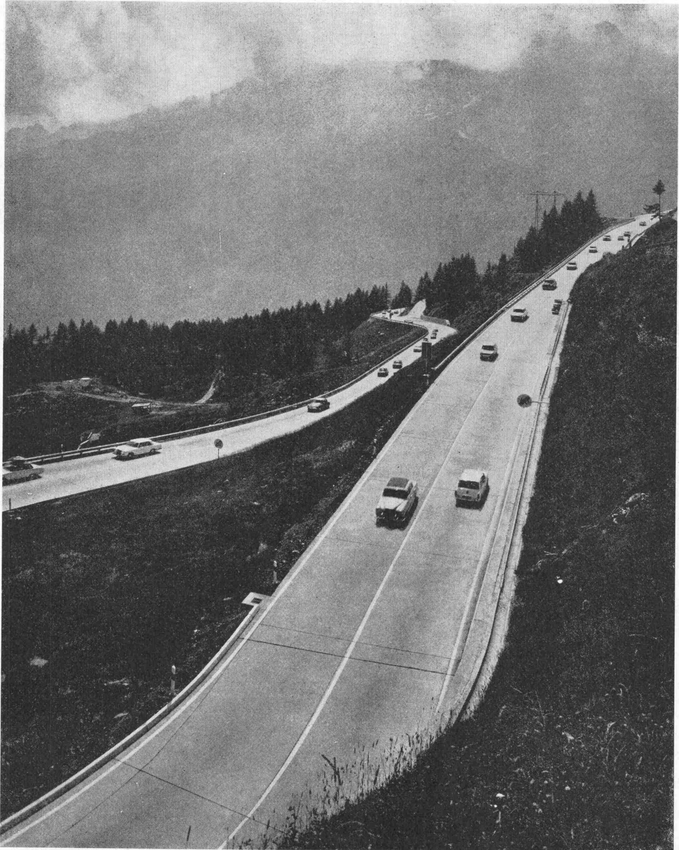
Nationalstrasse N2, Gotthard-Südrampe, Betonbelag
