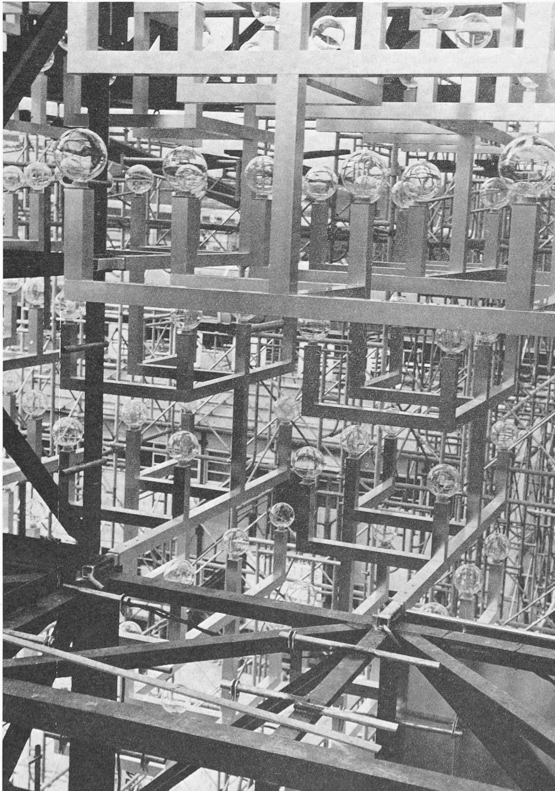
Aluminiumäste, auf die Stahlkonstruktion montiert
