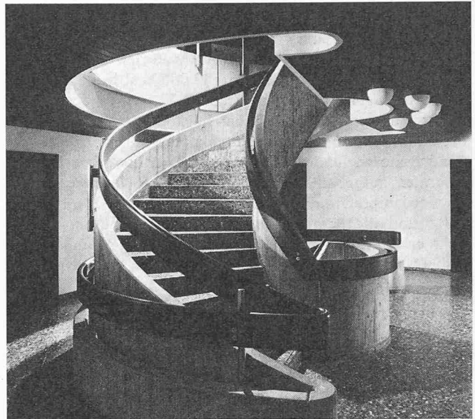
Runde Haupttreppe aus Sichtbeton. Stufen Kunststein, eichener Handlauf. Decke mit Irokoholz verkleidet
