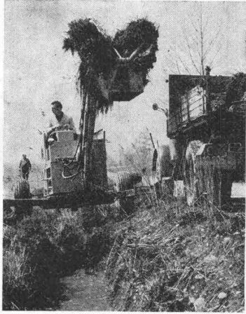
Arbeit mit dem Grabenlöffel
