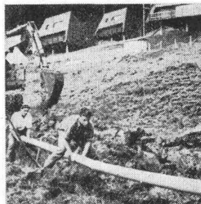
Kanalisation Schwyz : Rothenturm
