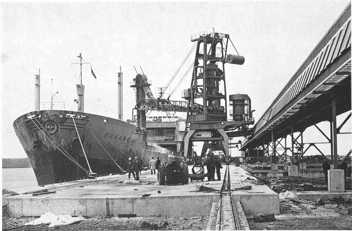
Die Tonerde-Ladung wird mit Hilfe des besonderen Hebers gelöscht. Rechts die gedeckte Förderbandbrücke
