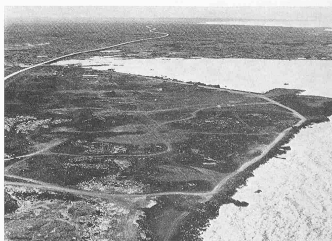
Bild 7. Ausführung der Spreng- und Planierarbeiten. Im Hintergrund ist die Hauptstrasse nach Keflavik ersichtlich
