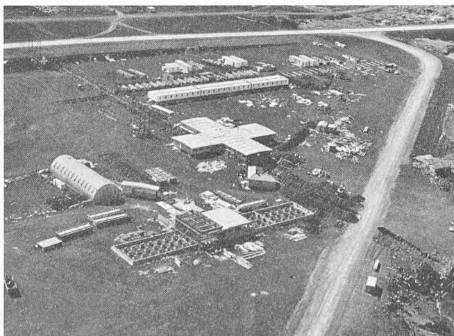
Bild 8. Montage des vorfabrizierten Büros (Vordergrund), der Kantine und der Schlafbaracken (Hintergrund)
