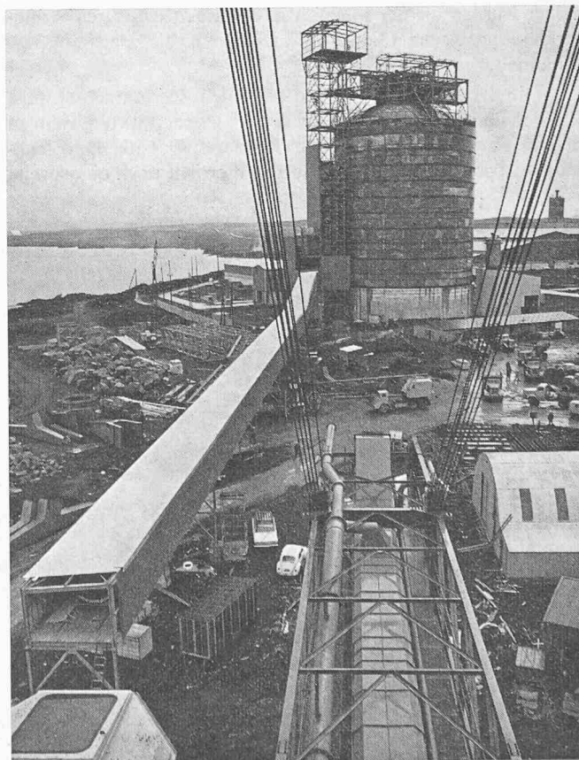
Bild 16. Der 30 000-t-Tonerdesilo während des Baues. Im Vordergrund die Förderbandbrücke
