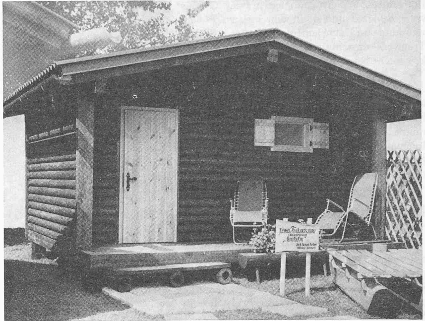
Bild 4. Wochenendhaus, gebaut unter weitgehender Anwendung von RUHO-Elementen
