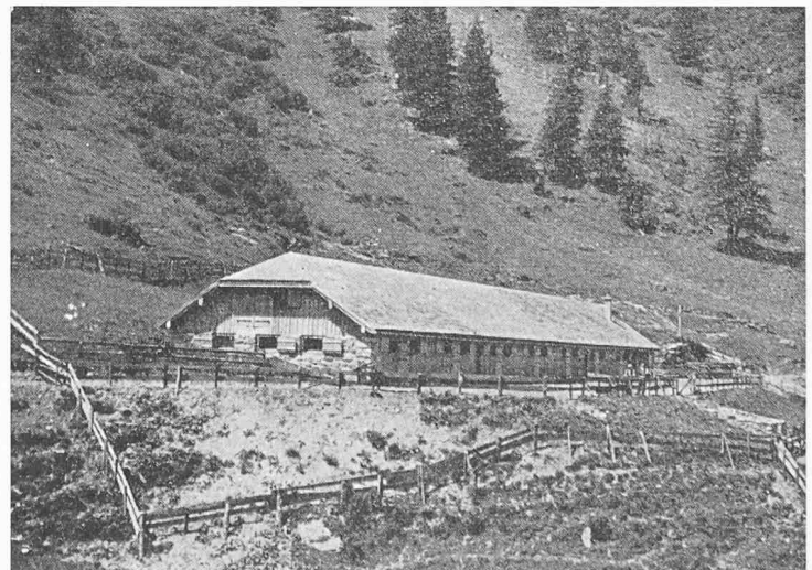
Bild 2. Querstall auf Alp Kohlschlag Mittelsäss, Gemeinde Mels, für 160 Grossvieheinheiten mit angebauter Hütte (rechts), erbaut 1947; Baukosten 103 000 Fr.
