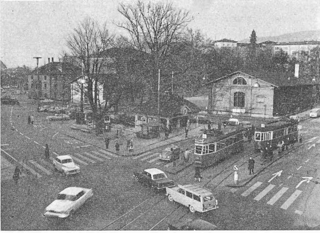
Blick auf den Heimplatz («Pfauen») gegen das heutige Kantonsschulareal (ganz hinten rechts das Gymnasium, erbaut 1839/42 von G. A. Wegmann). Die beiden Turnhallen werden dem künftigen Ausbau weichen müssen
