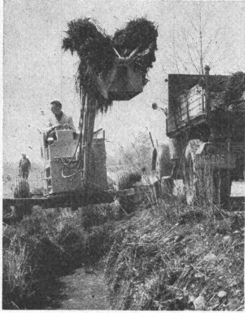
Arbeit mit dem Grabenlöffel
