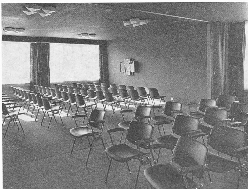
Vortragsraum und Fernsehraum (geöffnete Faltwand) im Erdgeschoss
