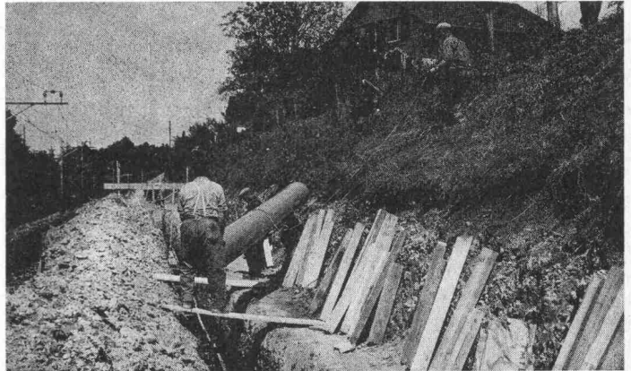
KALIDUR-Kanalisationsrohre, verlegt im Bahneinschnitt
