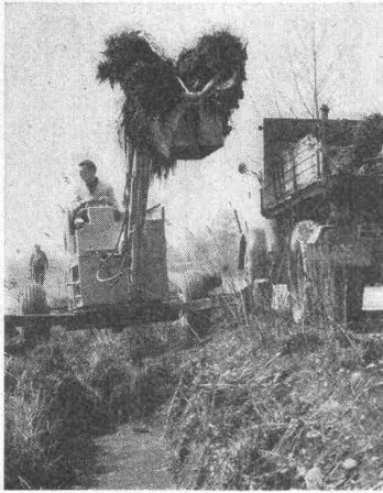
Arbeit mit dem Grabenlöffel
