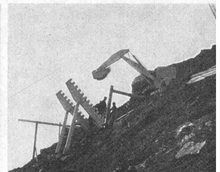
Einsatz bei Lawinenverbauungen
