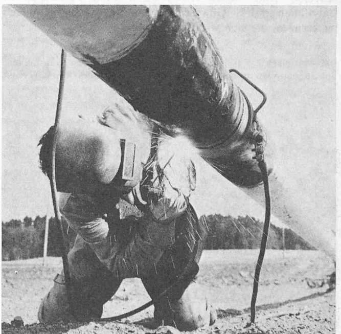
Bild 27. Schweissen der Rohre auf dem Felde (Photo Usogas)
