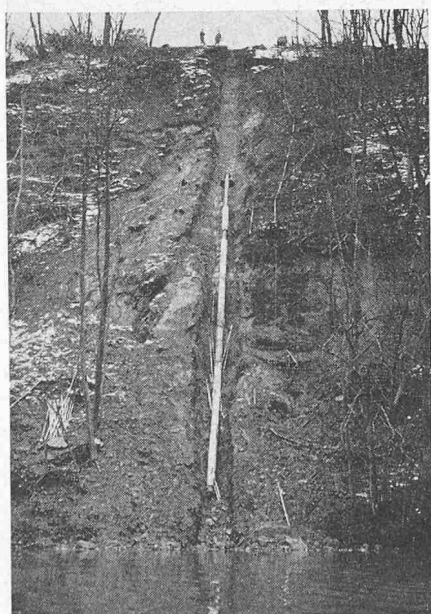
Bild 8. Rheindüker Eglisau. Die Überwindung des 44 m hohen linken Steilufers verlangte umfangreiche Sicherungsmassnahmen gegen Rutschungen (Photo Usogas)
