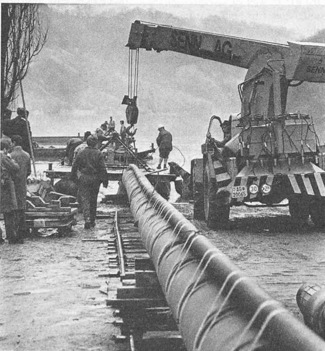
Bild 10. Verlegung des Rheindükers Eglisau. Einschwimmen des Rohres (Photo Comet)
