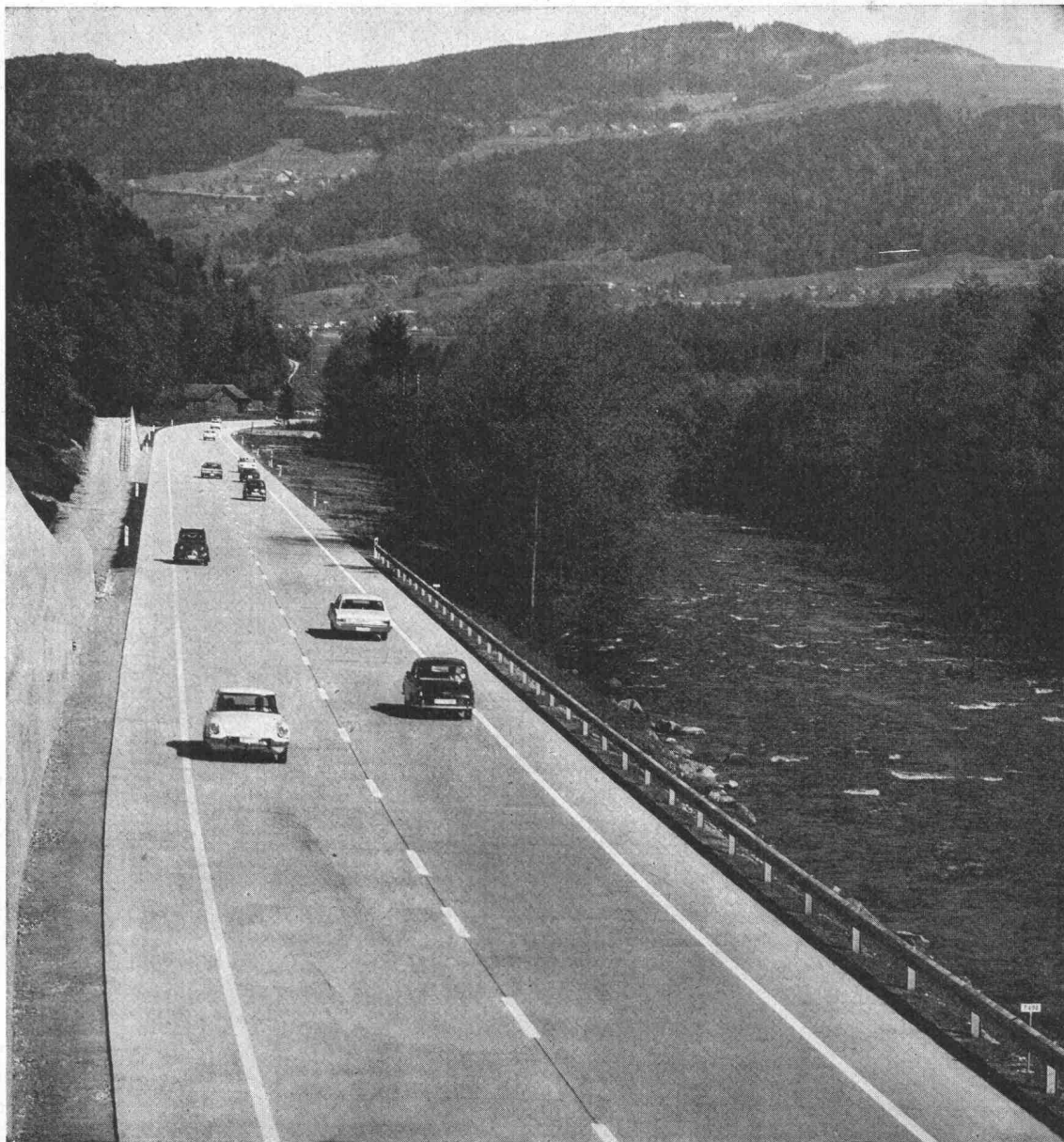
T 10 Luzern—Bern bei Malters LU Betonbelag
