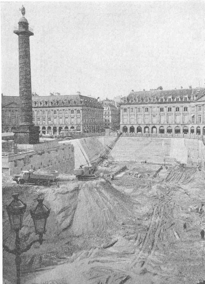
Bild 6. Baugrube für unterirdische Parkgarage Place Vendôme in Paris. Sicherung eines historisch bedeutungsvollen Bauwerkes mittels einer verankerten, partiellen Baugrubenwand
