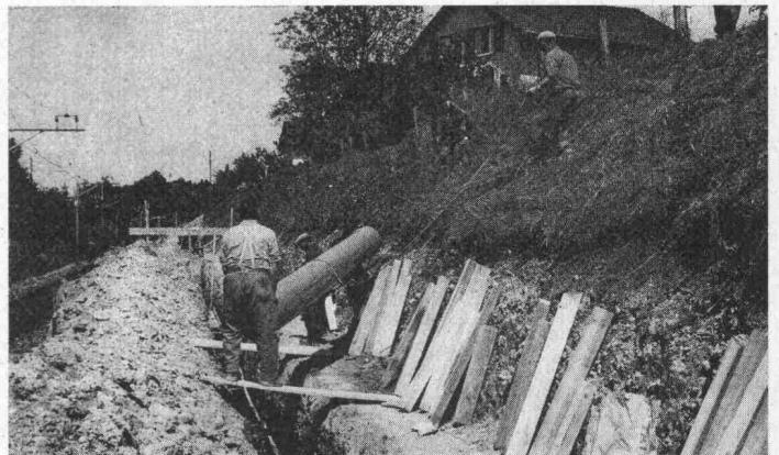
KALIDUR-Kanalisa-tionsrohre, verlegt im Bahneinschnitt
