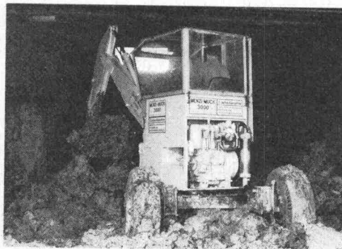
Bagger-Einsatz beim Bau einer Strassenunterführung
