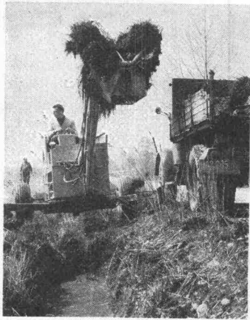
Arbeit mit dem Grabenlöffel
