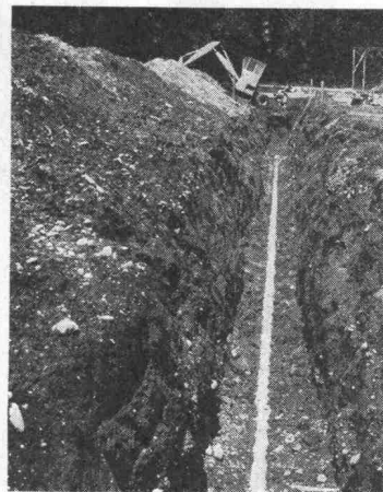
Graben für eine Rohrleitung
