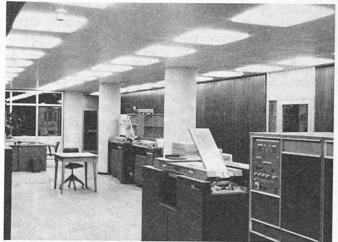
Bild 15. Computerraum mit «Unipro»-Montagedecke. Die Metallplatten sind mit Schnappverschlüssen an den Profilen der Unterkonstruktion befestigt
