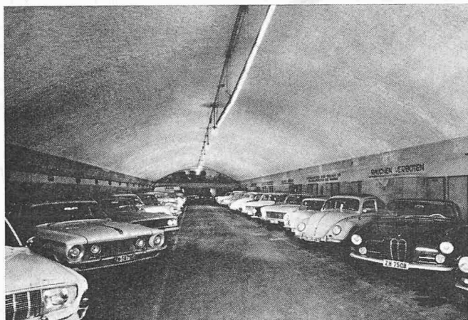
Bild 6. Luftschutzanlage Central, Zürich. Friedensnutzung als Parkgarage. Die in diesem Beitrag erwähnten Zürcher Parkhausbeispiele Central, Hohe Promenade, Urania, wurden vom Verfasser projektiert (Red.)
