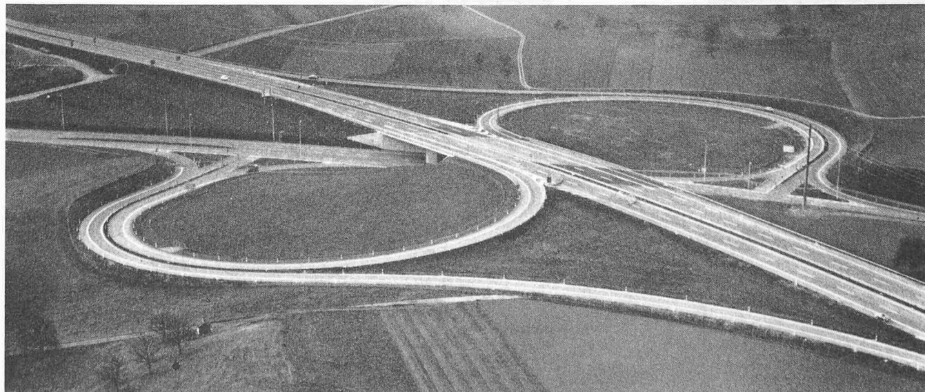
Bild 1. Autobahn-Anschlussbauwerk in Oberwinterthur, als halbes Kleeblatt ausgebildet. An dieser Stelle beginnt die neueröffnete Teilstrecke
